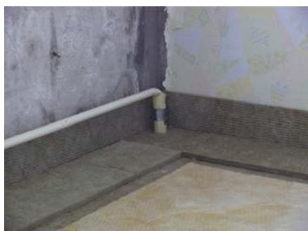
**3. Прокладка коммуникаций.** Во избежание образования «акустических мостиков» трубы отопления оборачиваются виброизолирующей лентой Вибростек-V300 (или аналогом). Электрические кабели и другие коммуникации можно «спрятать» в толще звукоизолирующих плит в нижнем слое. Это позволяет не проводить дополнительных работ по прокладке кабелей по стенам и углам помещения.
